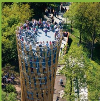
Jüberturm im Sauerlandpark in Hemer
